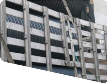
Amarrar la tubería con poleas anchas no metálicas, así se evita la posibilidad de cortar o dañar la superficie de la tubería.
