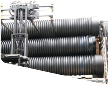
Las actividades de carga y descarga se deben realizar con el máximo cuidado. Las tuberías no deben arrojarse al suelo, recibir golpes o estar expuestas a soportar grandes pesos. A pesar del bajo peso de la tubería estructurada corrugada pead TecnoPIPE®, se recomienda que por lo menos dos personas se encarguen de estas actividades y con ayuda de equipos mecánicos si las tuberías son mayores a 400mm.
