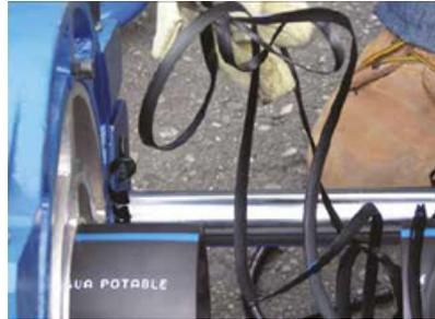
3 Aplique una presión mínima uniforme en ambas caras de la tubería o tubería-accesorio para asegurar una viruta constante en ambos lados. Mantenga la refrentadora en movimiento mientras separa las tuberías para evitar daños en los bordes.
