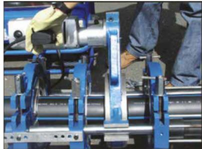
**1** Determine la distancia adecuada entre los dos extremos de la tubería para permitir un ajuste adecuado en la refrentadora.
